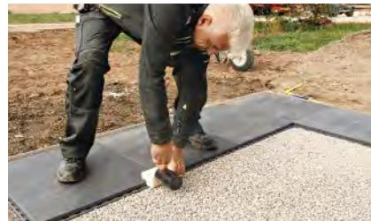
9. Überprüfen Sie dass Verriegeln der Platten und korrigieren Sie ggf.
