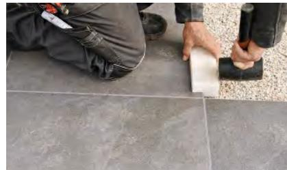
13. Überprüfen Sie Platte für Platte das Verriegeln des Klicksystems und korrigieren Sie nötigenfalls hier sofort.
