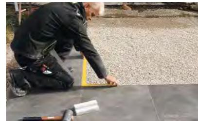
10. Überprüfen Sie die Rechtwinkligkeit der bereits verlegten Platten mittels Bauwinkelmessler.
