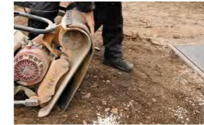
16. Abrütteln der fertig verlegten Fläche mittels Rüttelplatte mit einem Maximalgewicht von 60 kg und einer 2 cm Gummiauflage.
