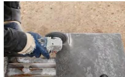
14. Zuschneiden der Platten mittels belüfteten Feinsteinzeug Diamanttrennblattes oder Nassschneidemaschine.
