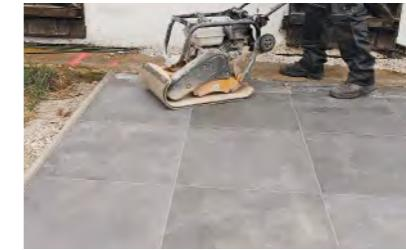
17. Um eine Beschädigung der Oberfläche und der Fugen zu vermeiden, müssen Sie die Fläche vor dem Abrütteln zwingend säubern.
