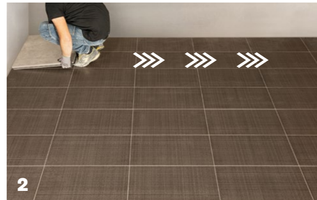
2 Die erste Platte rechtwinklig beginnend an der Wandcke verlegen. Install the first element, placing it perpendicular with the adjacent walls.
