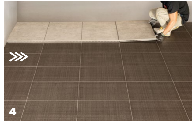
4 Die nächste Platte anlegen und festklicken. Bei der Verlegung von rechts nach links arbeiten, bis die Reihe vollständig ist. Continue installing, interlocking all elements on the right side, until the space is full.
