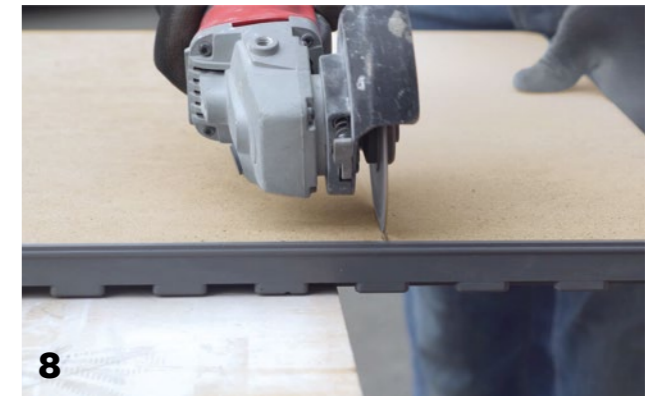
8 Zum Schneiden der Platten eine Fliesenschneidmaschine oder einen Trennschneider verwenden. Elements can be cut with a tile cutter or angle-grinder.
