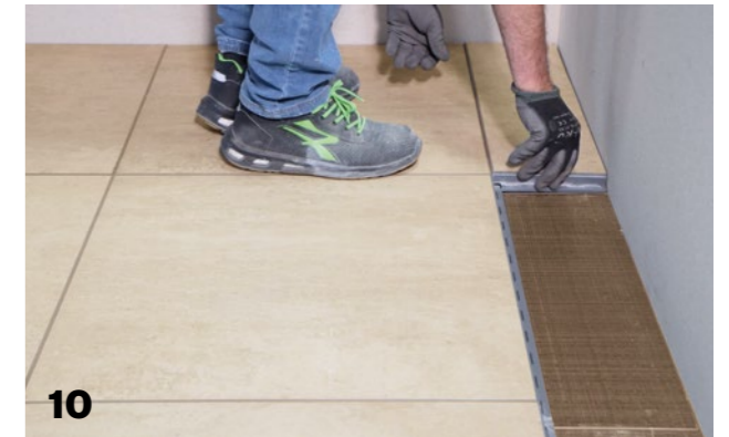
10 Den Abstand zwischen Platte und Wand ggf. mit Silikon ausfüllen. Fill any gaps between the elements and the wall with silicone.
