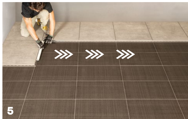
5 Nach Beendigung der ersten Reihe die zweite Reihe erneut von rechts beginnen und stets darauf achten, dass die Platten rechtwinklig verlegt sind. When the first row is complete, start again from the beginning, always ensuring that the elements are perpendicular.
