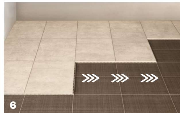
6 Die nächste Platte anlegen und festklicken. Bei der Verlegung von rechts nach links arbeiten, bis die Reihe vollständig ist. Continue installing, interlocking all elements on the right side, until the space is full.
